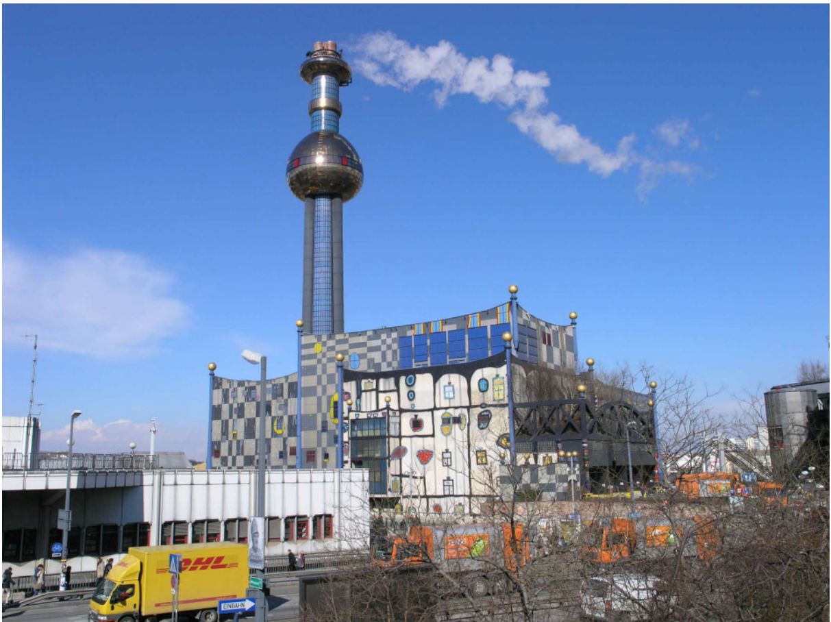
Figure 4. Friedensreich Hundertwasser, Spittelau district heating plant, Vienna. (Photo Lukas Riebling http://commons.wikimedia.org )
